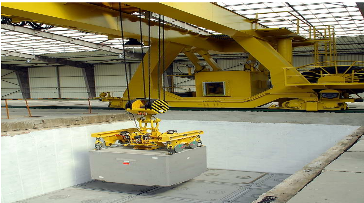
Obr. Ukladanie VBK do úložných boxov úložiska v 1. dvojrade
